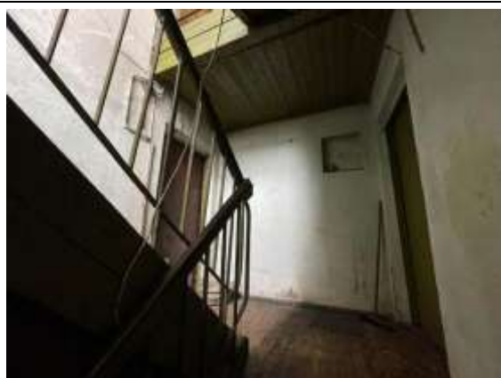
1.stāva kāpņu telpa
